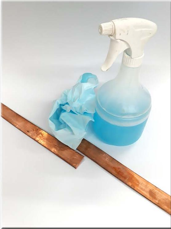
Die beiden Enden der Erdbänder müssen mit Kaltreiniger oder Nitroverdünnung fettfrei gereinigt werden. Das Kupfer muss blank sein, nötigenfalls muss es angeschliffen werden.
