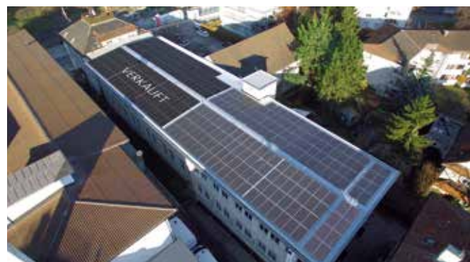
PV-Anlage Schiesser-Areal, ChrüzlingeSolar.
